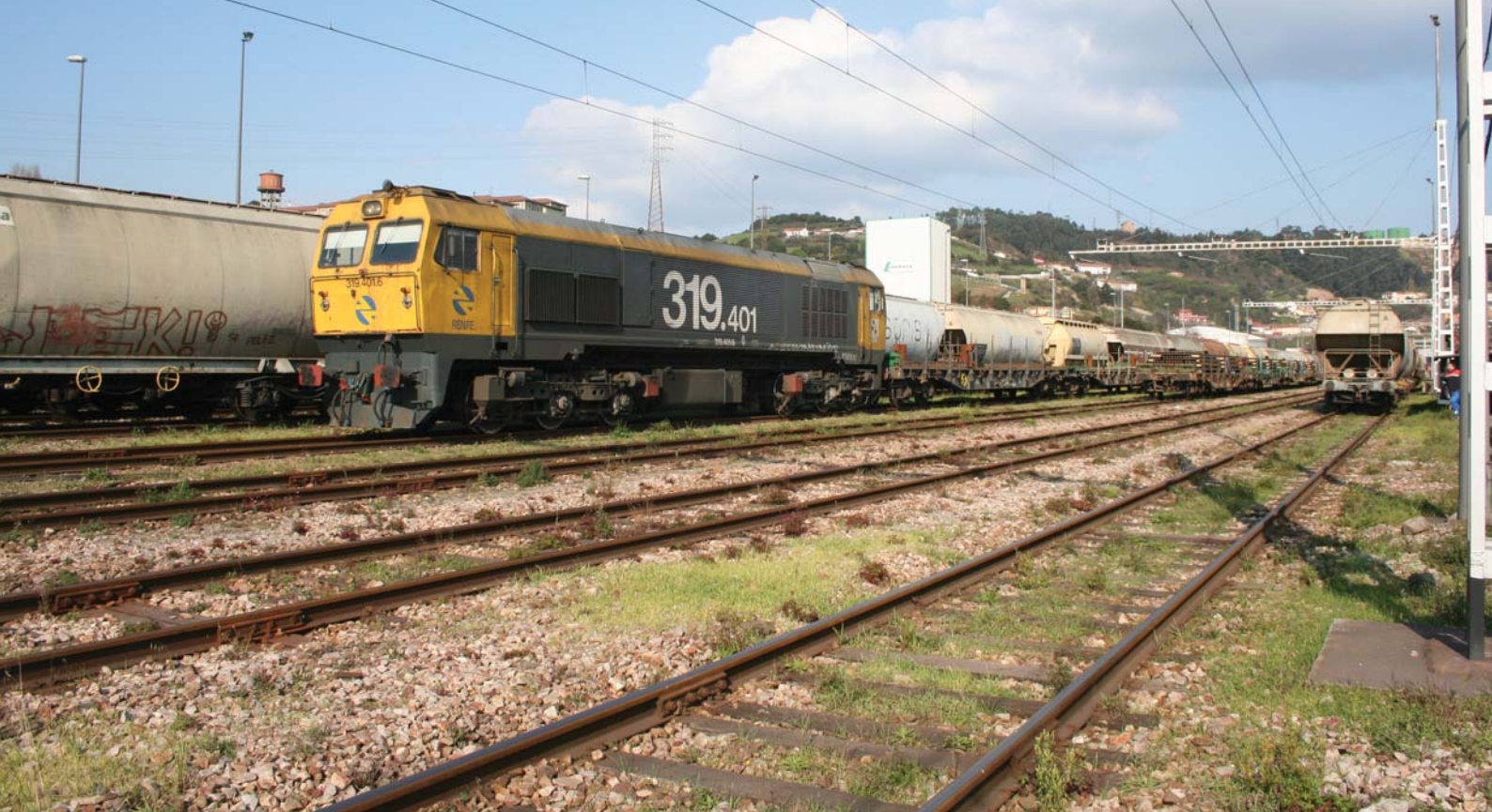
Estación del puerto de El Musel. Las grandes áreas logísticas, playas de vías para trasiego de trenes de mercancías, suelen montar todavía traviesas de madera. Foto: Daniel Pérez Lanuza.
